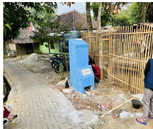
Sumber: (Dokumentasi Penulis, 2026) Gambar 3. Rocket Stove yang sudah jadi di Kelurahan Cigoong
