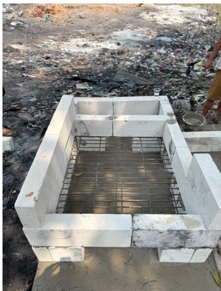
Gambar 4. Struktur Bawah Rocket Stove
