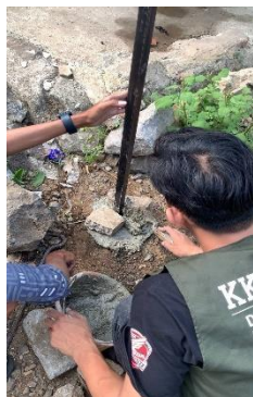
Sumber: (Nisrina salsabila, 2026) Gambar 3. Pemasangan Plang Penunjuk Jalan
