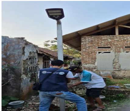
Gambar 2. Pemasangan Penerangan Jalan Umum Berbasis Panel Surya.
