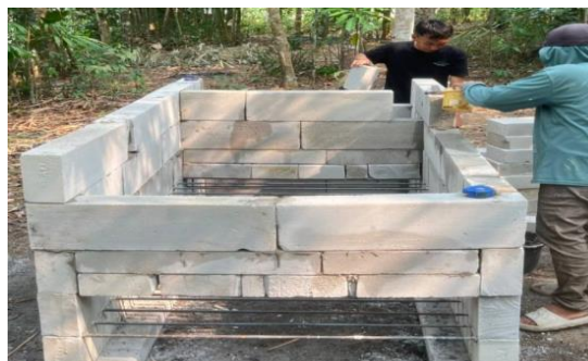
Sumber : (Dokumentasi Penulis, 2026) Gambar 5. Proses Pembuatan Rocket Stove
